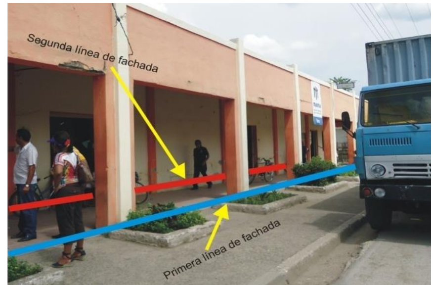
Fig. No 7. Primera y Segunda líneas de fachada en edificaciones
