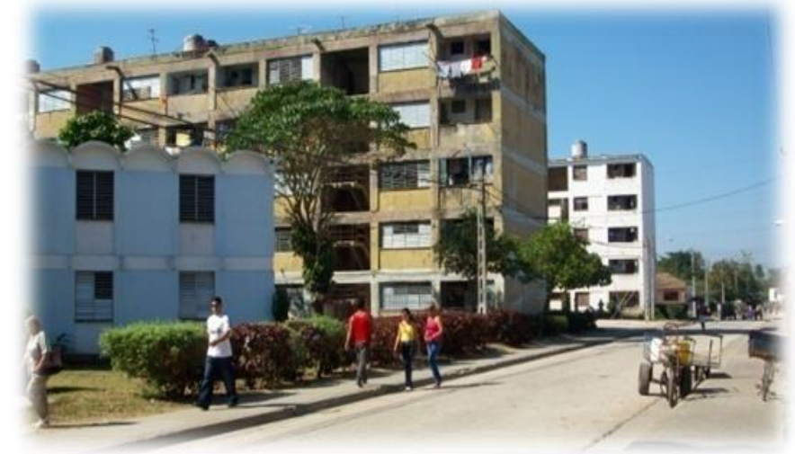
Fig. No 14. Edificios Multifamiliares entre uno y cinco niveles.
